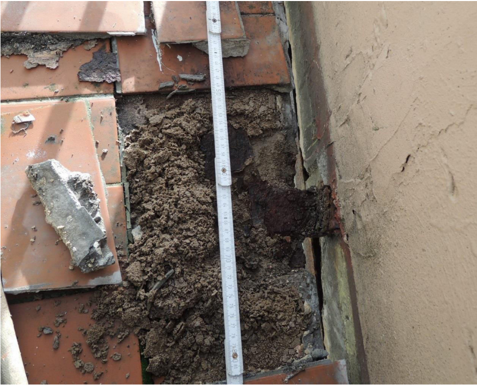
Foto 17. Krt. 106. Lahti tehtud alumine kinnituselement.
