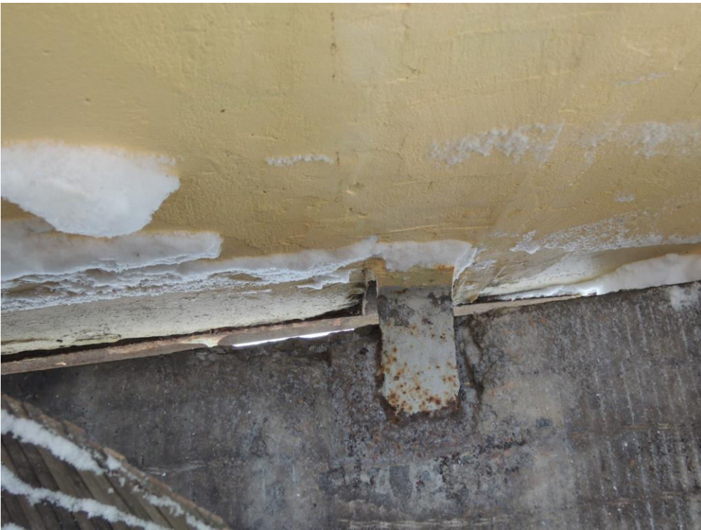
Foto 09. Krt. 75. Alumine kinnituselement.
