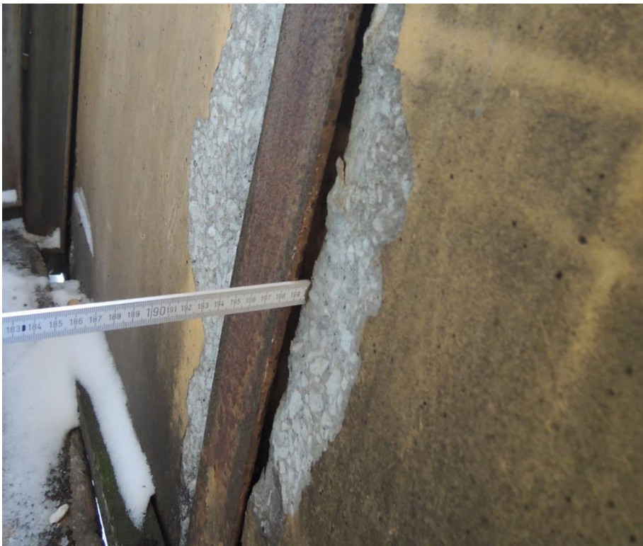
Foto 22. Krt. 137. Piirdepaneel on kumerdunud väljapoole, keskel ~1.0-1.5cm võrra.
