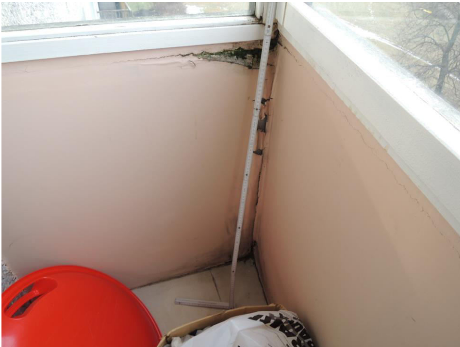
Foto 21. Krt. 126. Niiskusega kahjustatud rõdu piirdetarindi nurga siseviimistlus.
