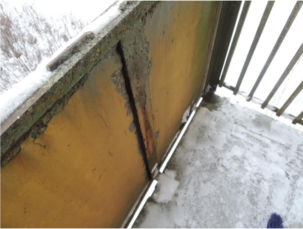
Foto 11. Krt. 79. Pragunenud piirdepaneel.
